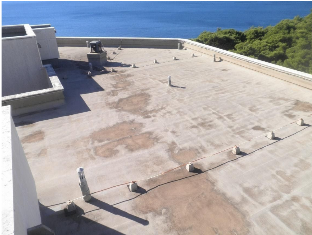
Slika 23: Krov dilatacije D
