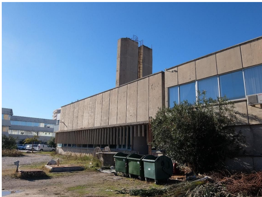
Slika 25: Istočno pročelje dilatacije E
