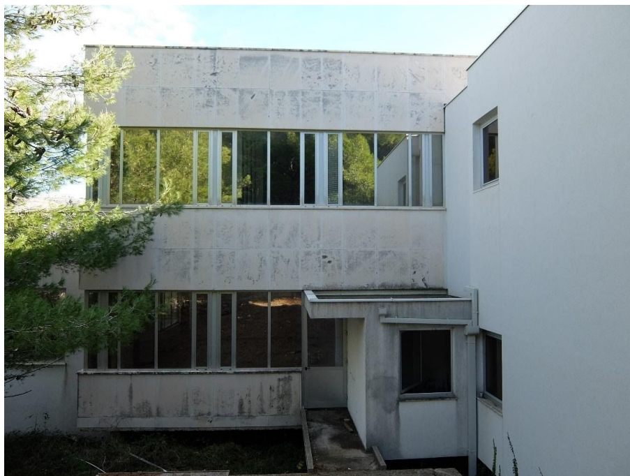
Slika 16: Zapadno pročelje dilatacije C
