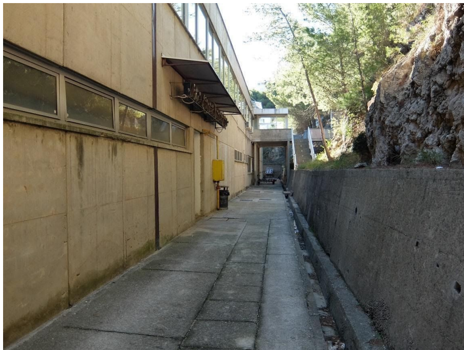
Slika 27: Zapadno pročelje dilatacije E
