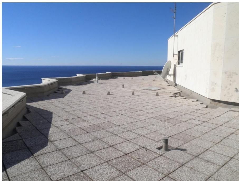
Slika 22: Krov dilatacije D
