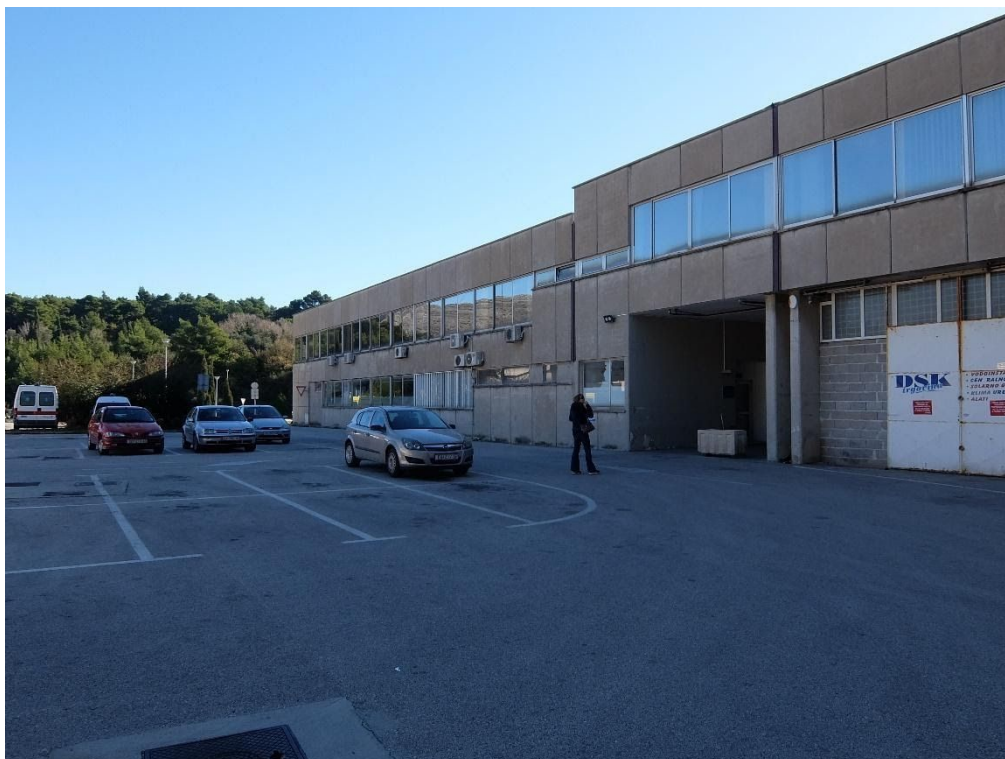
Slika 24: Sjeverno pročelje dilatacije E
