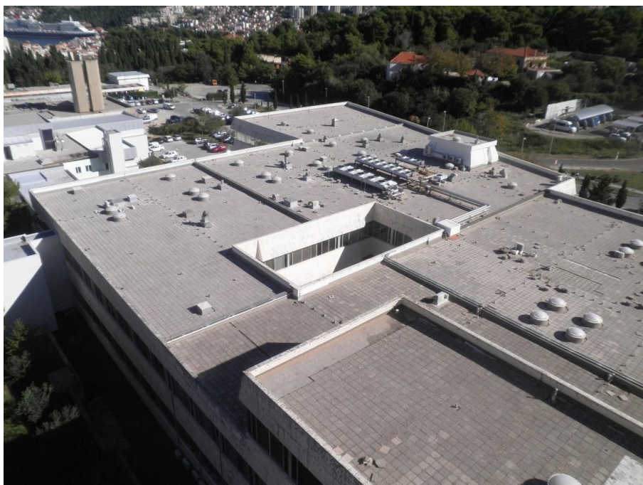
Slika 17: Zapadno pročelje dilatacije C
